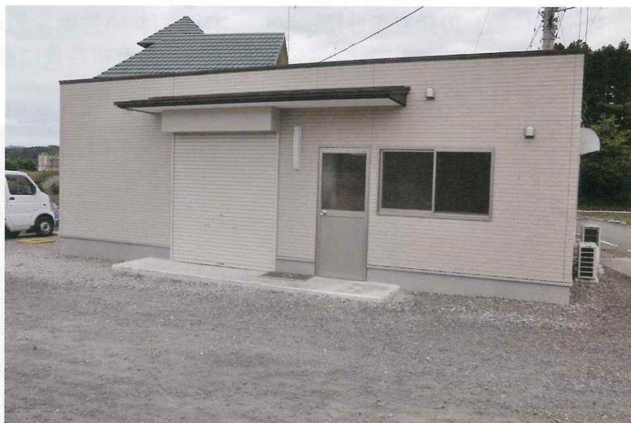
▶ 完成した落花生加工施設
